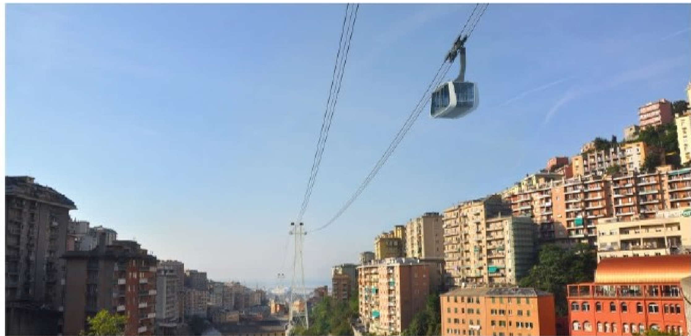
VISTA PANORAMICA VERSO SUD DEL 1° TRONCO FUNIVIARIO
